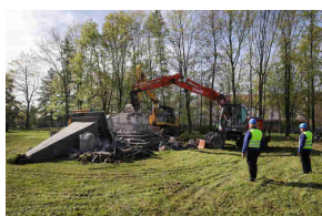
Demontaż sowieckiego obiektu propagandowego „wdzięczności Armii Czerwonej” - Grubczyce, 5 maja 2023/ FOT. M.Bujak IPN
